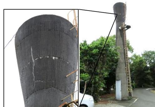
亀裂が入り、漏れた水が石灰化した箇所
