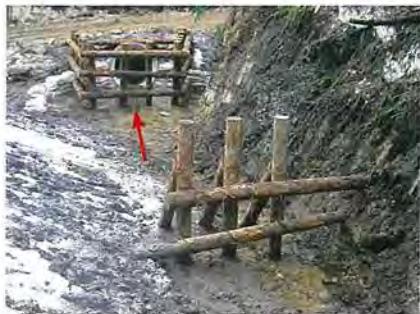
呑口保護工・流木除け工
