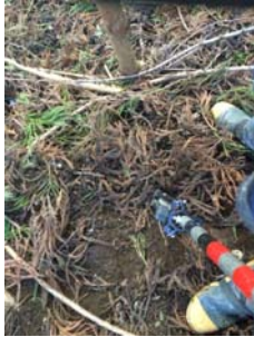
打設後1年以内に埋もれてしまった杭
