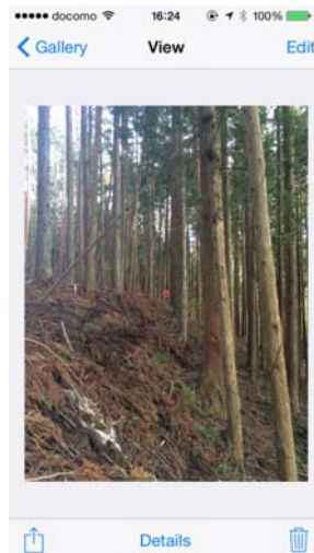
反射板の設置
