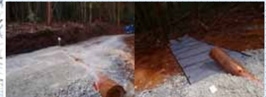
丸太利用の路面排水 (径20cm) 1km20基使用の場合
